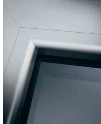
Glasleiste auf Gehrung Mitred glazing bead
