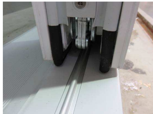
Bild 3 Innere und äußere Dichtungsebene (Schiebeflü- gel), unten
