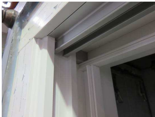
Bild 2 Äußere Dichtungsebene (Blendrahmen), Eckausbildung oben
