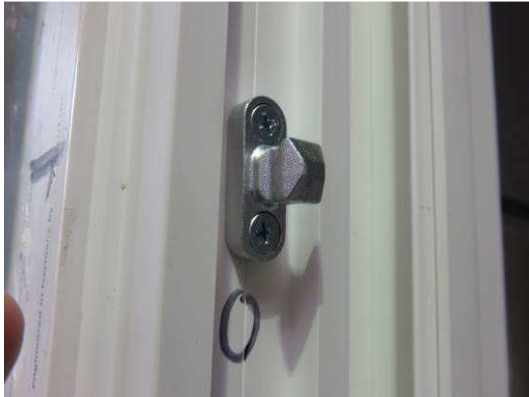
Bild 18 Verriegelungssituation Blendrahmen, Pos. 2
