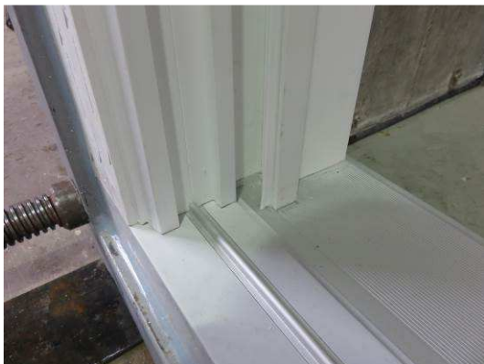
Bild 12 Schwellenanbindung, schließseitig unten
