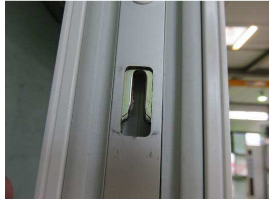
Bild 19 Verriegelungssituation Schiebeflügel, Pos. 2
