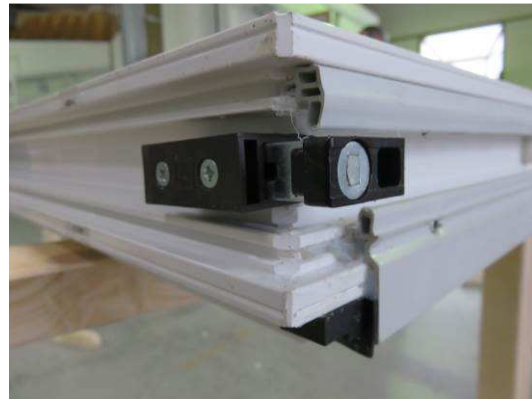
Bild 7 Innere und äußere Dichtungen Schiebeflügel, oben mittelbündseitig
