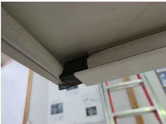
Bild 8 Dichtung Verhakungsprofil, oben
