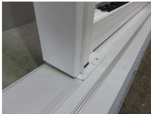
Bild 13 Schwellenanbindung am Festfeld, unten, ohne Schiebeflügel
