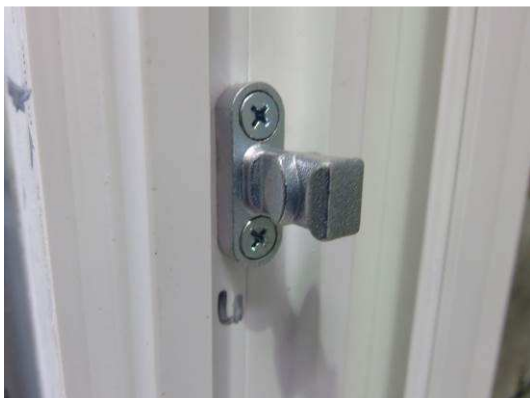
Bild 16 Verriegelungssituation Blendrahmen, Pos. 1
