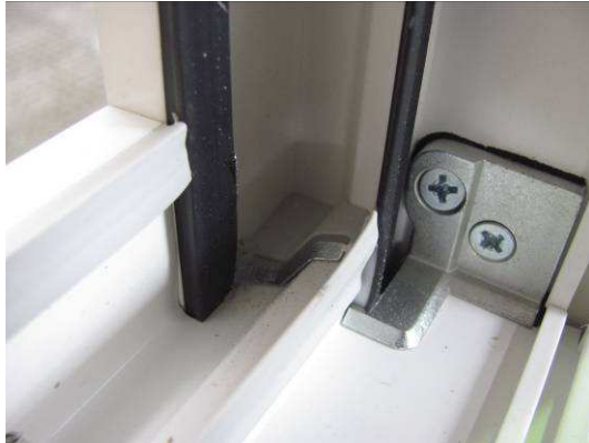
Bild 1 Falzansicht des Kreuz-Verbinders
